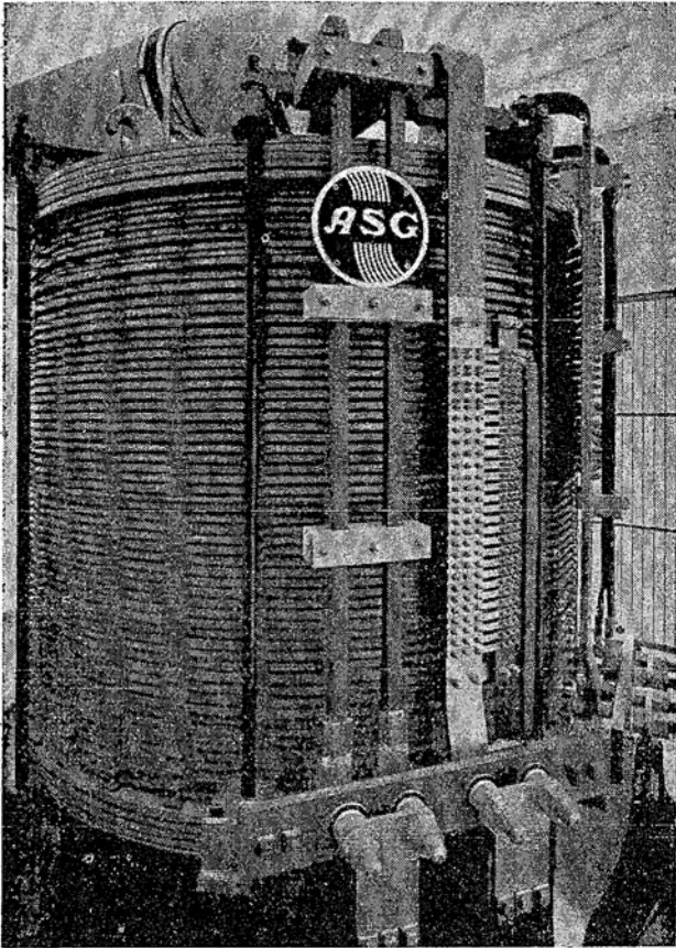
Fig. 10 - Induttore di protezione.
