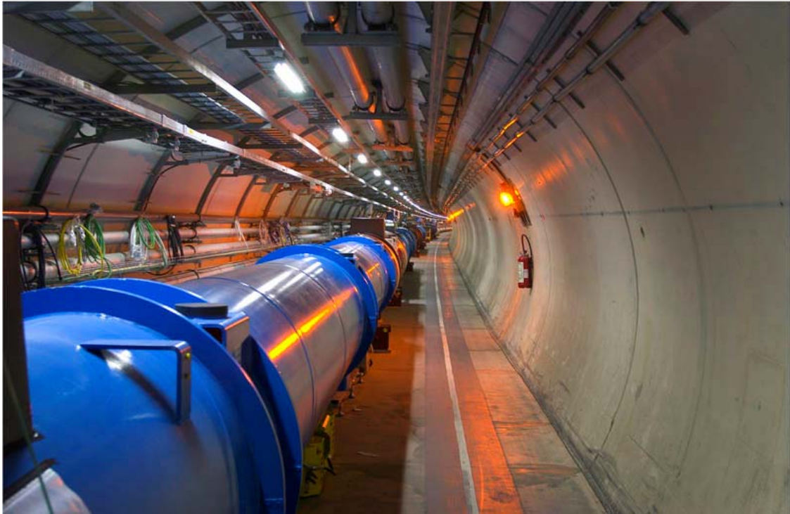
Figura 2.2 – Tunnel di LHC
