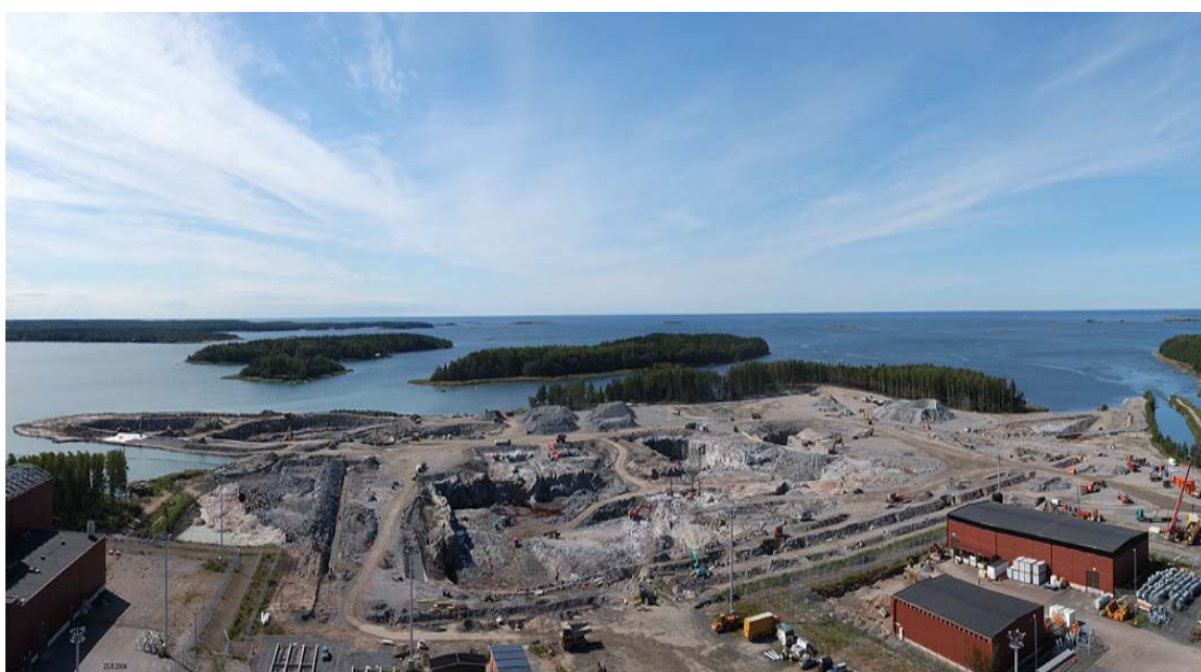
FIG. 11: Il sito nucleare Finlandese di Olkiluoto, come si presentava nel Dic 2003, all'inizio dei lavori di scavo per la realizzazione di OL3 70,71) .
