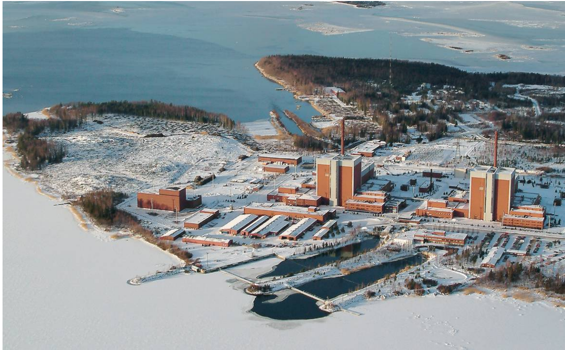
FIG. 12: Il sito nucleare Finlandese di Olkiluoto come si presentava nel Feb 2004, dopo i primi scavi per i lavori di costruzione della terza unità di potenza OL3.
