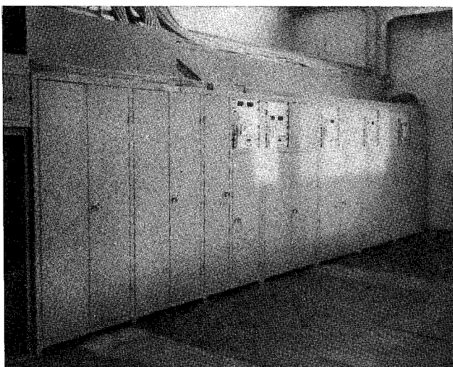
FIG. 73 - Nuovi alimentatori per i magneti dipolari e quadrupolari di ADONE.
