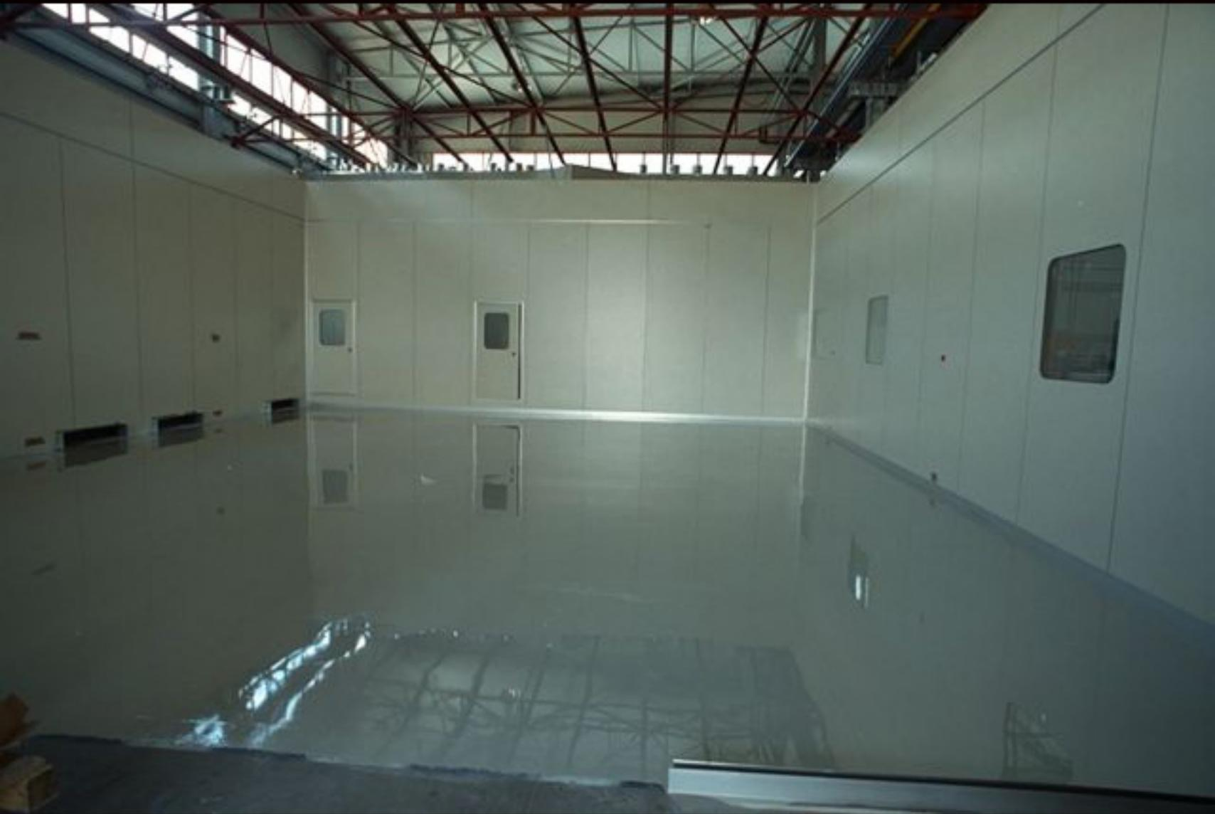
Zona protetta dall'intrusione di polveri e condizionata per impedire escursioni termiche. Si è utilizzata per costruire la camera a deriva, cilindrica, lunga 4 m, di 2 m di raggio, necessaria al tracciamento delle traiettorie delle particelle cariche.
