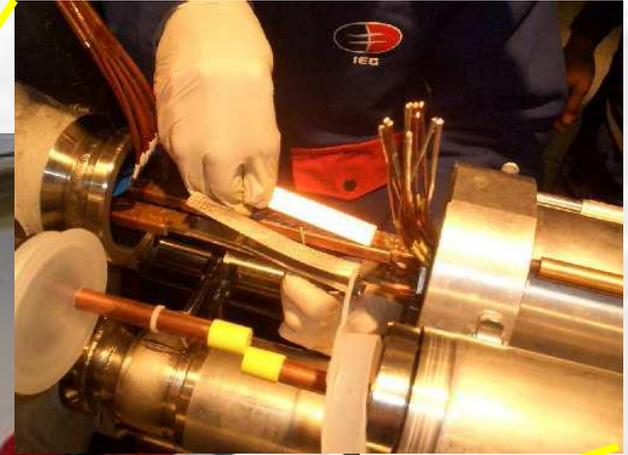
I magneti superconduttori di LHC sono interconnessi elettricamente da giunzioni in rame, saldate tra di loro (ce ne sono 30,000)
