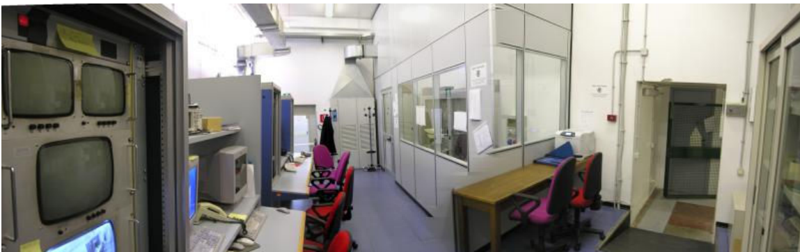
Vista della sala controllo della BTF
